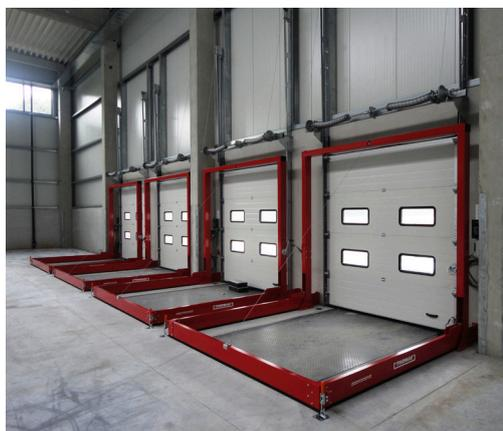
Le poids total de la barrière est réparti grâce à des câbles qui courent sur des poulies afin de faciliter sa manutention.
